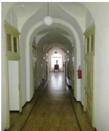
Zona scolasticato, 2° piano: camere corridoio S. Giovanni Canzio
